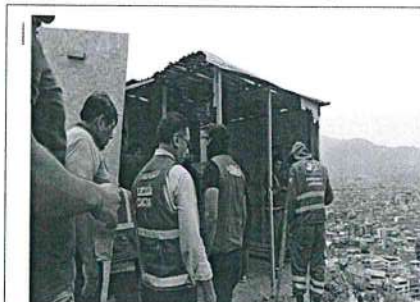
Retiro de módulo de madera, que ocupaba área común ilegalmente
